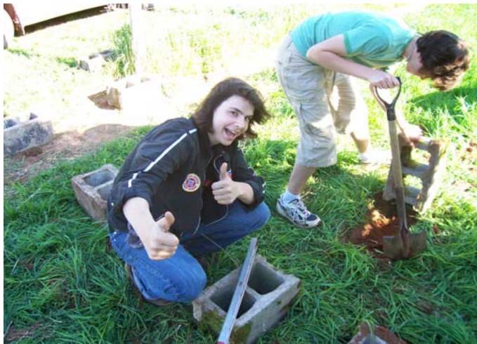
Et voilà: Foundation is finished !!!
